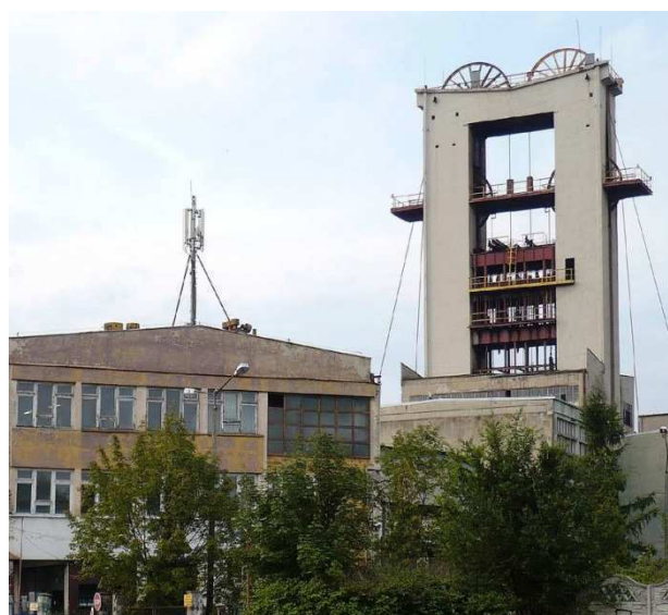
Szyb Roździeński – Kopalnia Węgla Kamiennego „Wieczorek” w Katowicach.
