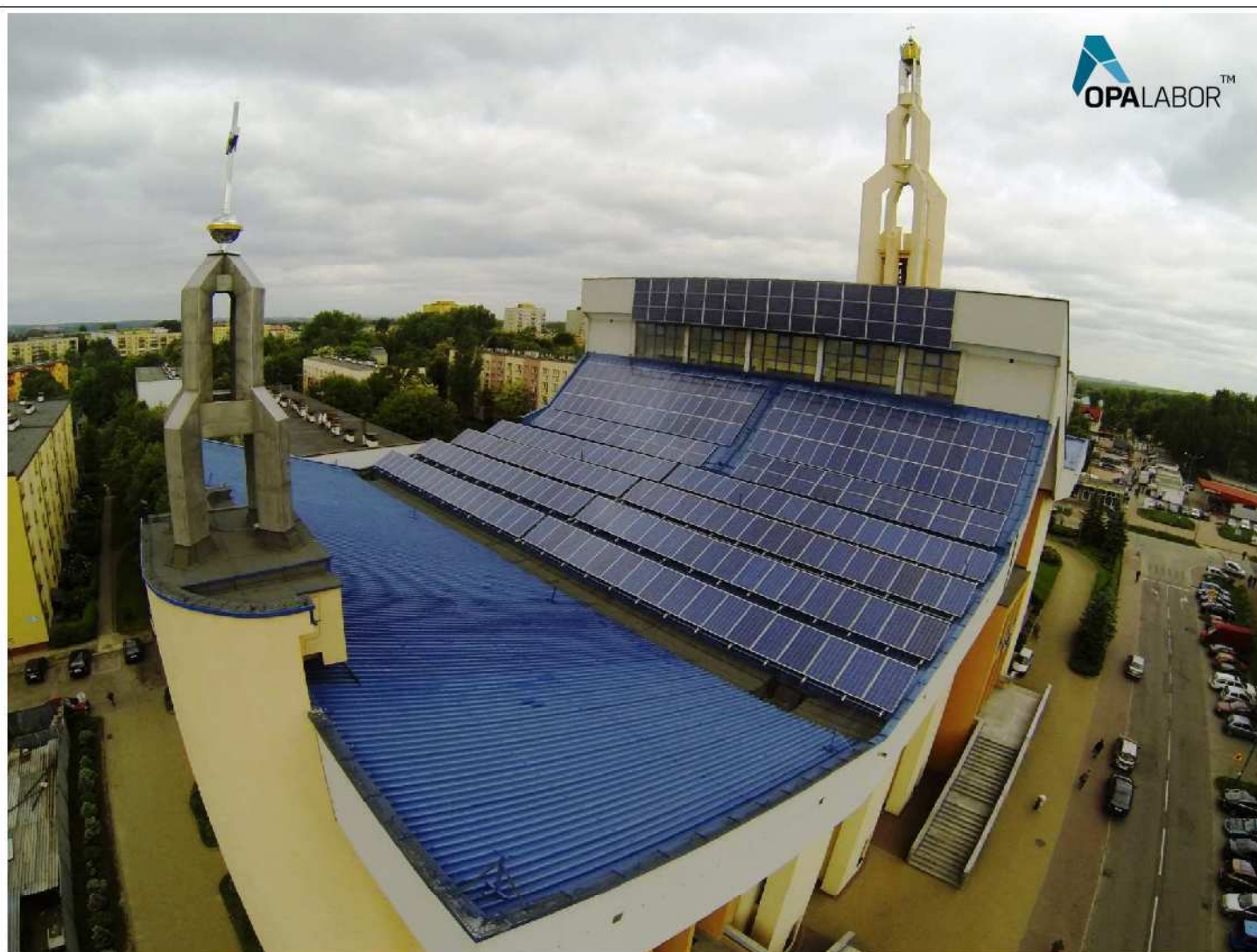
Na zdjęciu Sanktuarium w Jaworznie z zamontowanymi na dachu w trzech płaszczyznach modułami fotowoltaicznymi.
