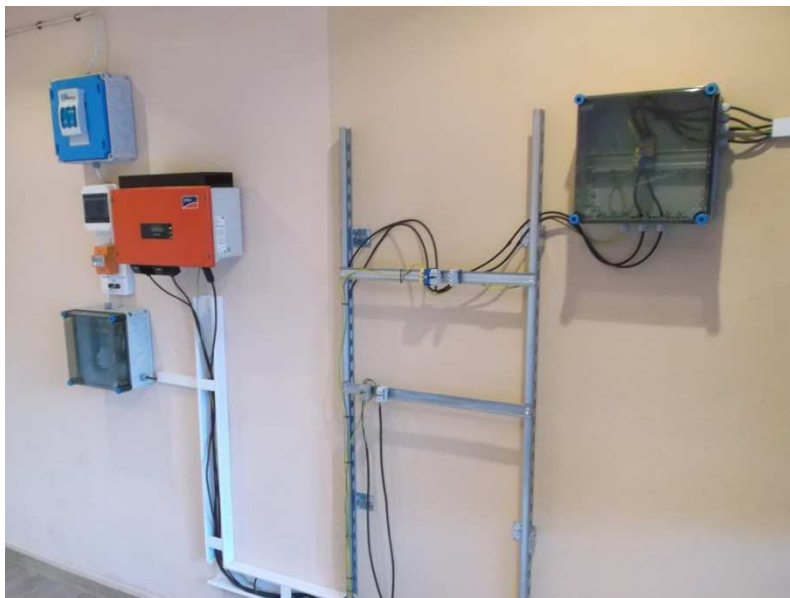
Montaż układu „on grid”
