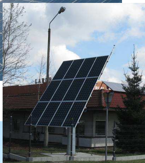
Na zdjęciach elektrownie fotowoltaiczne na dachu hali i na trakerze.
