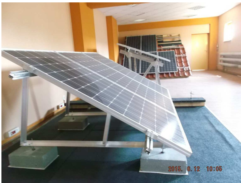
Montaż modułów na różnych powierzchniach.
